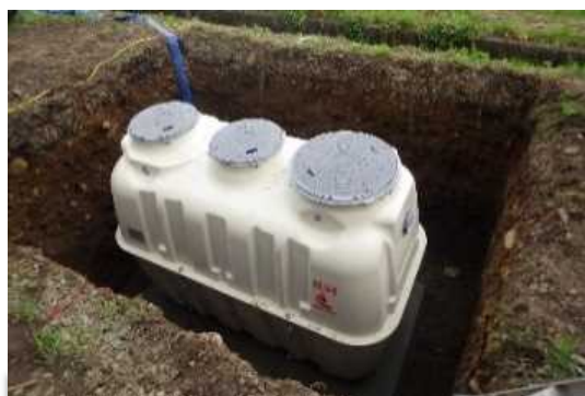
資産名称 浄化槽 耐用年数 28 年 令和 5 年度整備 5 人槽 6 基 7 人槽 7 基 10 人槽 2 基
