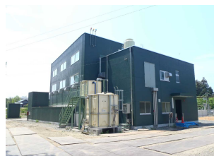
下川原ポンプ場
