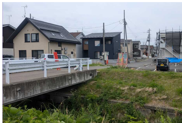
工事予定箇所 平沢川沿南側から撮影
