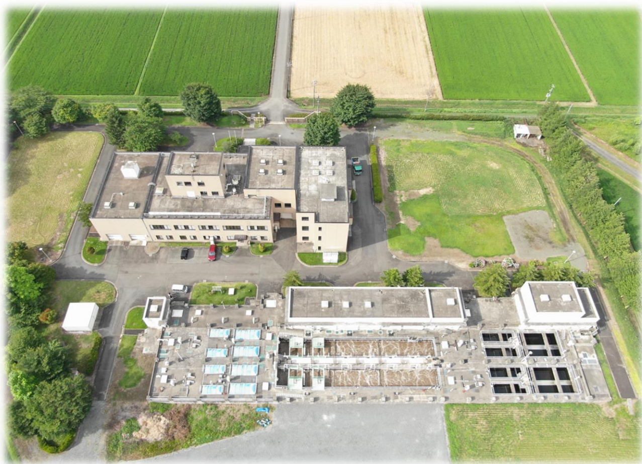
紫波浄化センター（南側より空撮）
